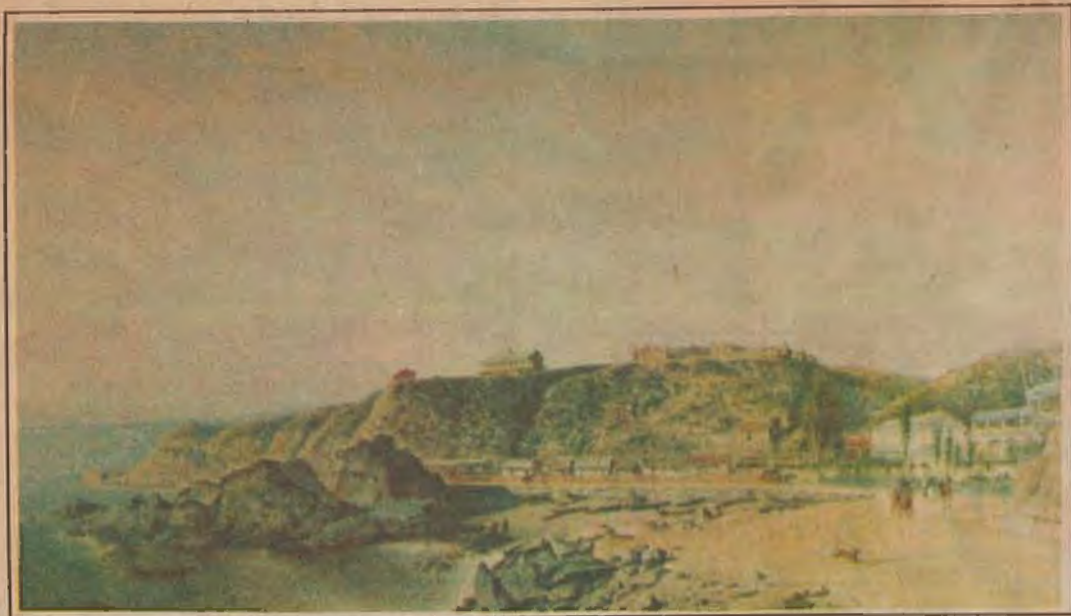
La Caleta El Membrillo, captada por el paisajista francés Desirée Chassin Troubert, en el que destacan algunas quintas de recreo que existían en el lugar y el comienzo de lo que es hoy la avenida Altamirano.
