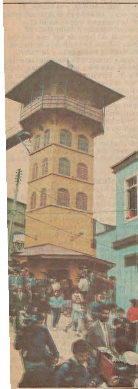
La típica torre del ascensor Polanco, declarado monumento nacional, captada el día en que se entregó su restauración.
